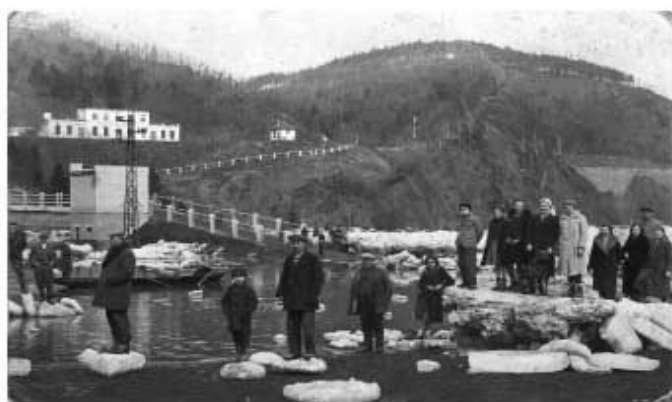
Dřenice v roce 1940 silně poškodila objekty, které byly následně zbourány: hotel Mašek, domy E. Chadimy, Jar. Laciny, Matěje Soukupa a další.
