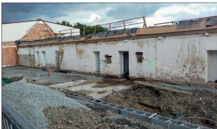
K 1. dubnu byla zahájena přístavba a nástavba základní školy na staré budově. Vlivem přestavby škola získá navíc pět kmenových tříd, tři odborné učebny a skladovací prostory. Více na str. 3.
