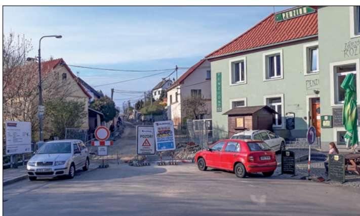
Od března do června byl opraven poslední úsek komunikace na Brunšově. Velkou zátěžkávací zkouškou pro novou silnici a dešťovou kanalizaci byly přívalové deště ve čtvrtek 6. června.
