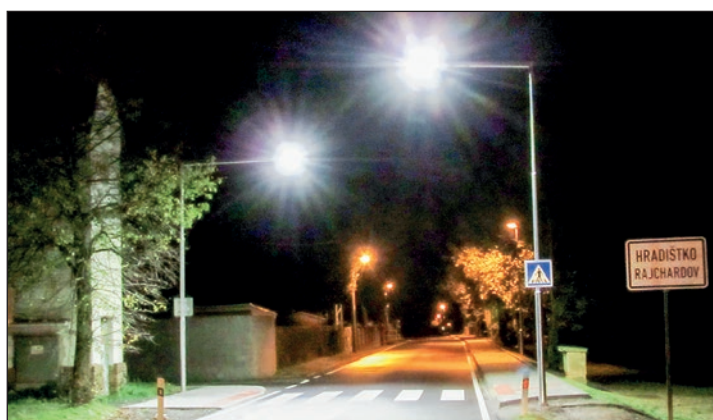
V průběhu podzimu byla dokončena další část etapy výstavby chodníku, tentokrát na Rajchardově v úseku od restaurace U Petra k trafostanici.
