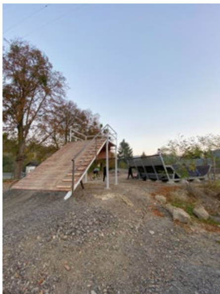
Rozjezd před dokončením a velká rampa v pozadí.
