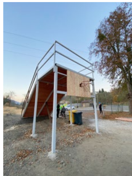
Na rozjezd jsme přidělali basketbalový koš a plácek před ním vyasfaltujeme.
