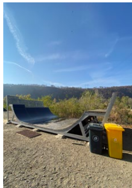
Velká rampa po dokončení.
